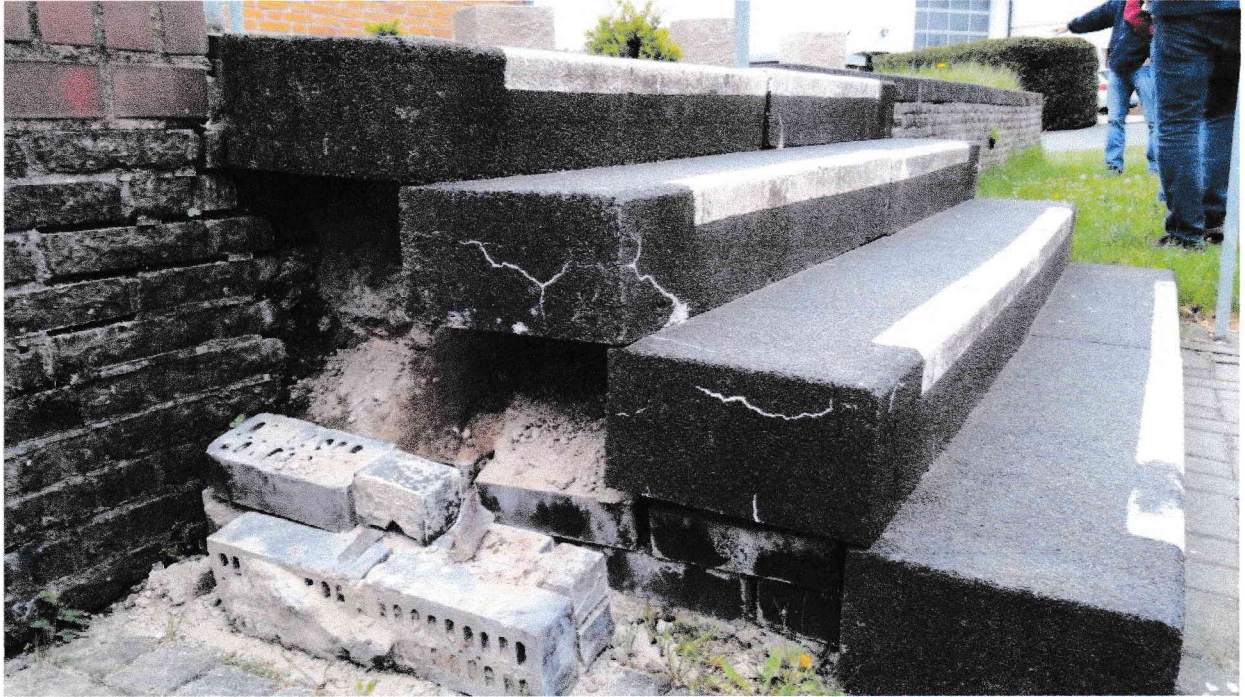
Bild 3: Eingangstreppe DGH Aufnahme 3
