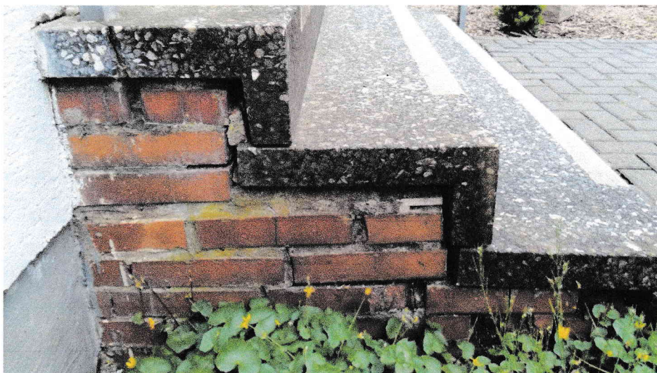
Bild 2: Eingangstreppe DGH Aufnahme 2
