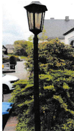
Bild 12: Laterne Eingangsbereich DGH
