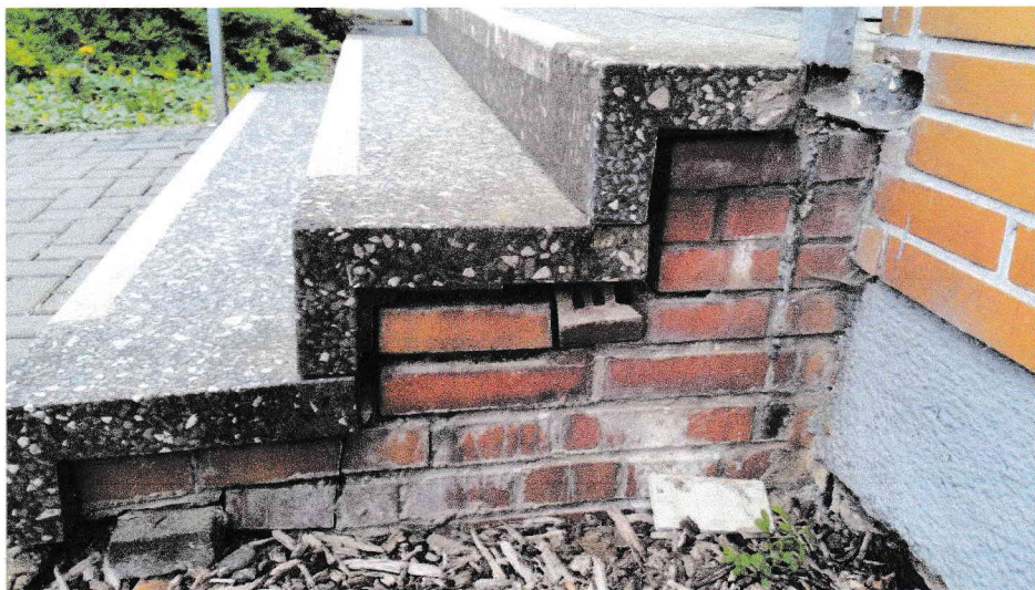
Bild 1: Eingangstreppe DGH Aufnahme 1
